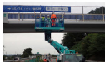
跨道橋の点検
