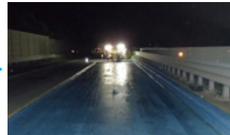
施工中イメージ
