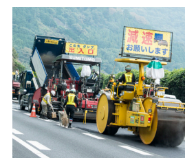
舗装補修工事
