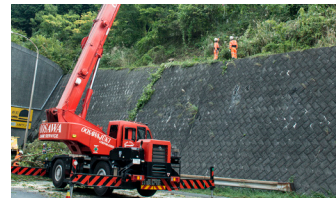
樹木伐採状況
