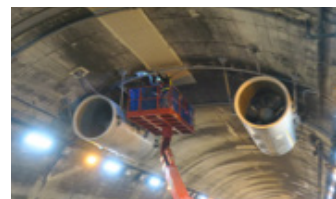
トンネル内施設の点検
