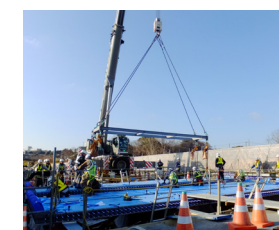
プレキャストコンクリートの設置
